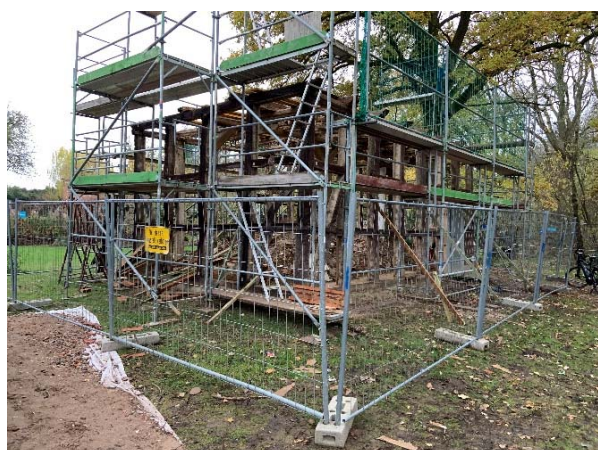
Abtragung des Gebäudes
