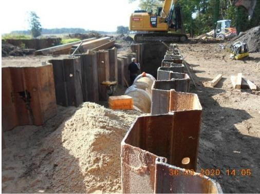
126 Baugrube des Rohrdurchlass unterhalb der Purnitz und der neuen Brücke
