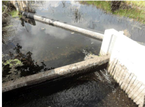
153 Notverschluss einer FAA bei Neuendorf am Damm aufgrund geringer Wasserstände im Secantsgraben (c) Knop
