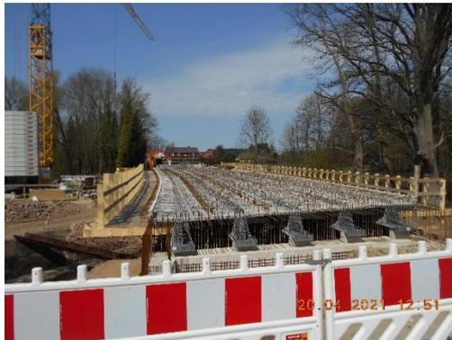
129 Bauseits montierte Fertigteilträger des Überbaus
