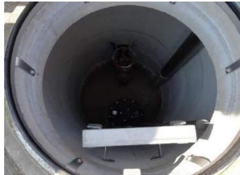
Abbildung 189: Brunnenstube, Wasserwerk Klötze
