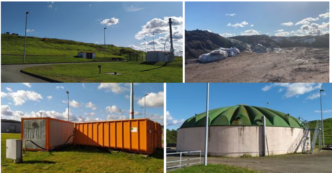
Abbildung 28: Deponiekörper der Deponie Lindenberg-Gardelegen mit Gasaufbereitung, Sickerwasseraufbereitungsanlage (Foto: GAVIA)
